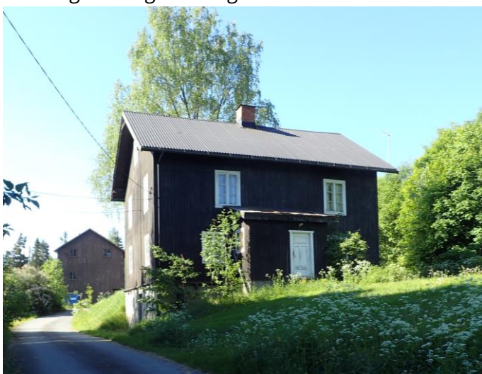
Våningshuset fra nord
