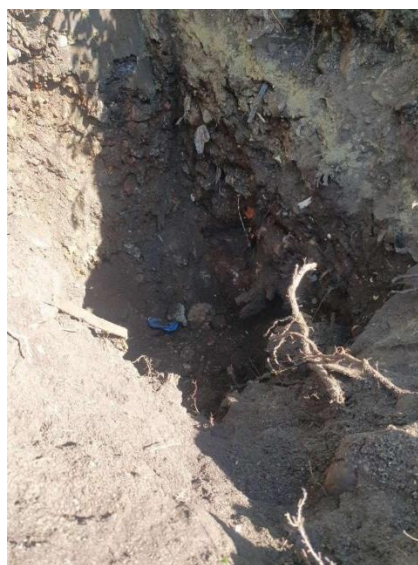
Bilde 2. Sjakt G5 (deponi) med avfall.
