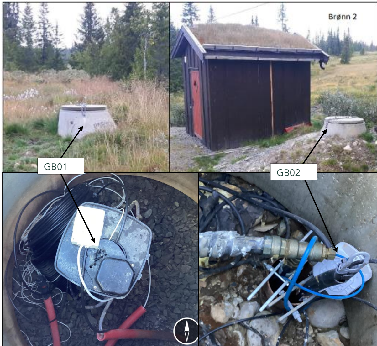
Figur 4: Oversikt over GB01 og GB02. Det øverste bildet viser brønntopp sikret med kumring og lokk. Vannbehandlingsanlegg til venstre for GB02. Nederst vises brønntopp til GB01 (venstre) og GB02 (høyre).
