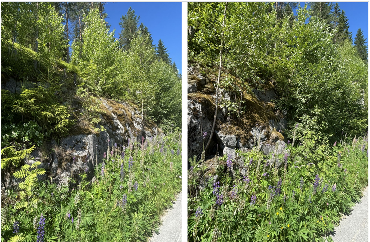
Figur 3-3: Berg i dagen tatt i Vest-Torpveien ovenfor tiltaksområdet. Bilde til venstre er tatt på starten av bergknausen mot nord, og bilde til høyre er tatt på samme lokalitet på den nordligste delen av knausen. Bilde til høyre viser noen oppsprukket berg. (Bilde: COWI).
