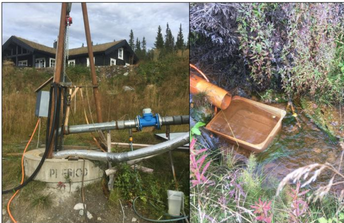
Figur 8: Hovedbrønnen og grunnvann fra borehullet som ledes ut til bekk.
