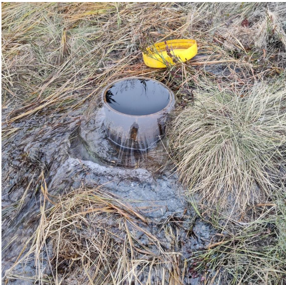
Figur 4: Bilde artesisisk brønn (brønn 2 etter boring).
